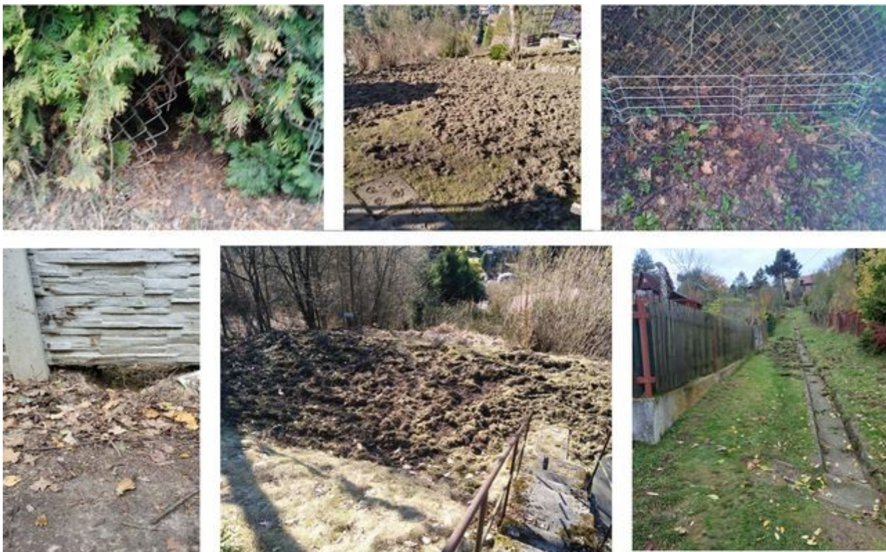
doraźna naprawa ogrodzenia
